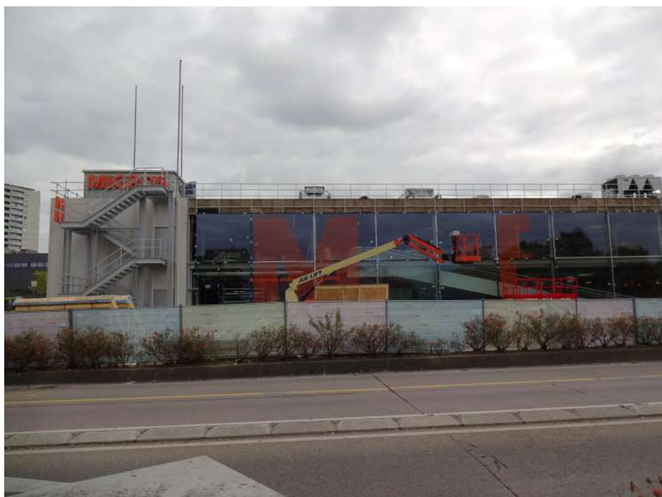
17 octobre 2020—la fin des travaux approche © Bernard BARD
