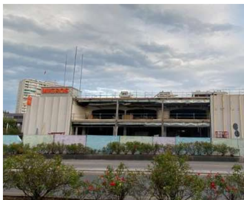
2020—pendant les travaux © DR
