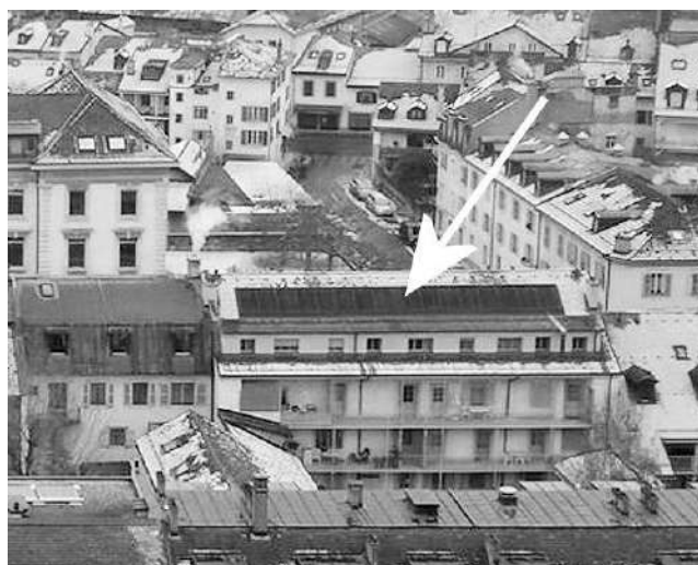
Panneaux solaires thermiques posés il y a quelques années à la rue Jacques-Dalphin.
